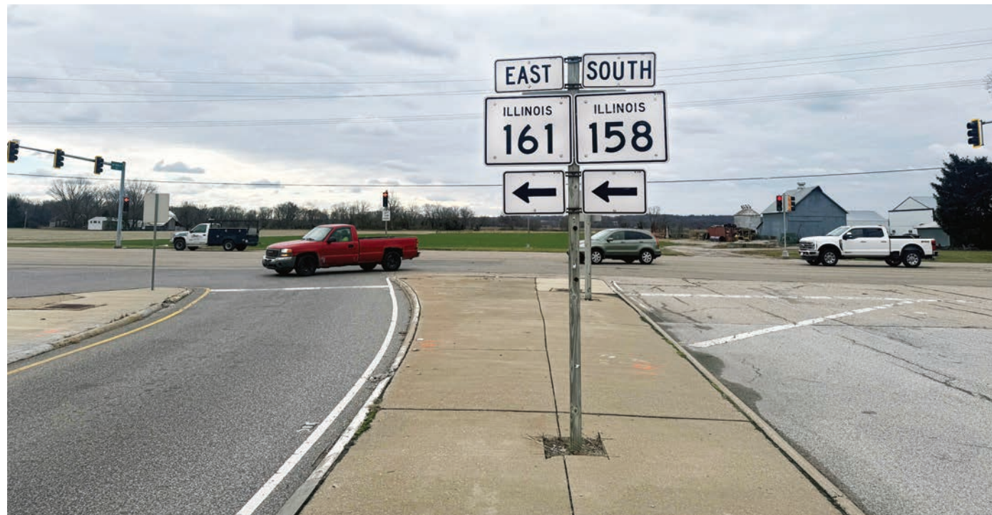
Current IL Rte. 161 and IL Rte. 158 intersection
